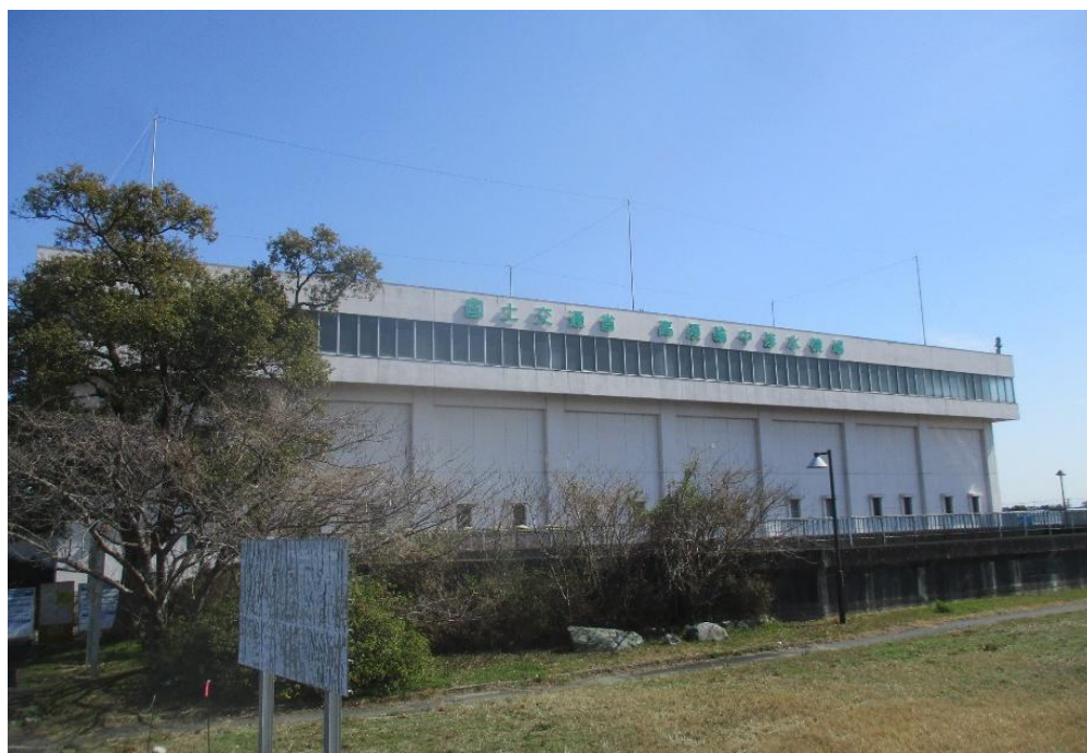
高須輪中排水機場
