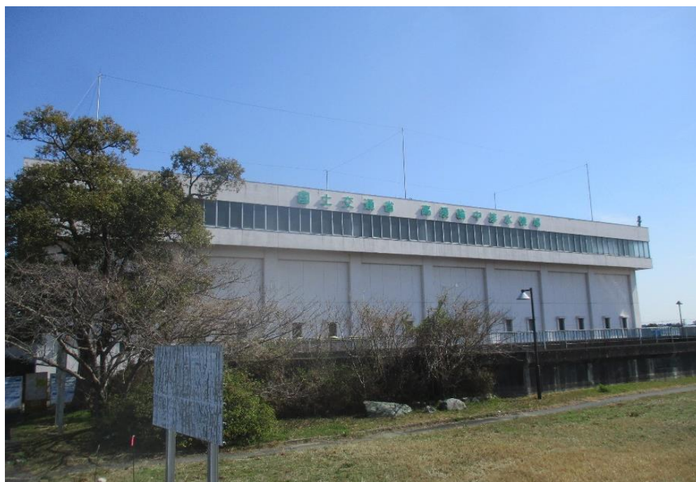
高須輪中排水機場
