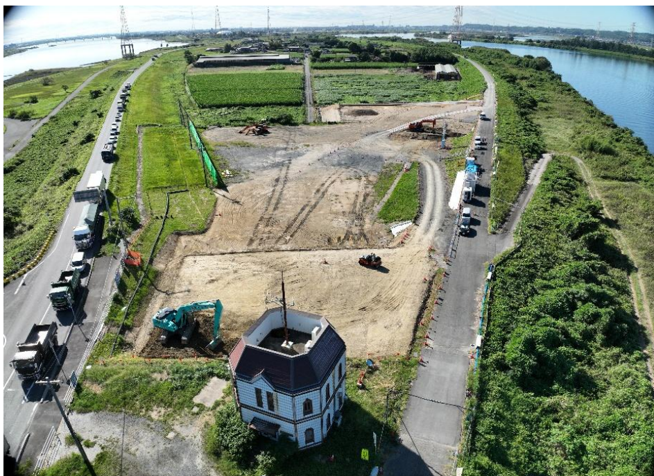
福原防災ST上流より望む
