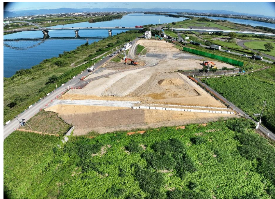
福原防災ST下流より望む
