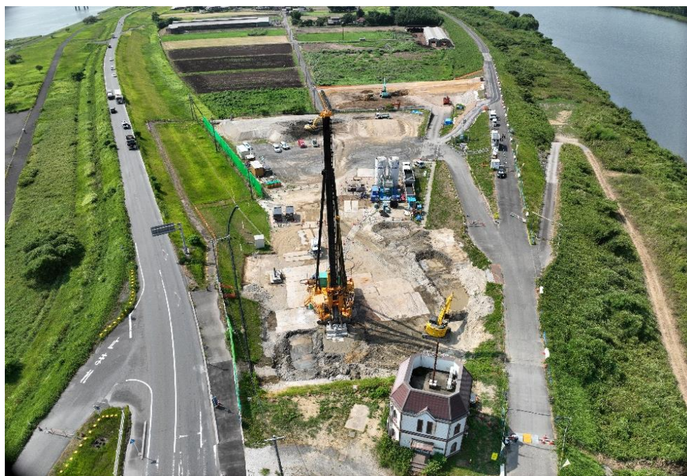
福原防災ST上流より望む
