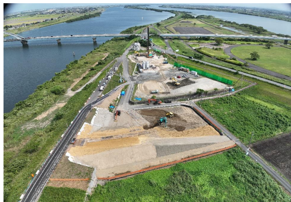
福原防災ST下流より望む
