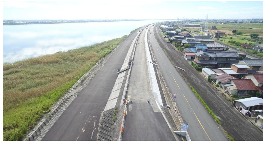
工事終点～下流を望む
