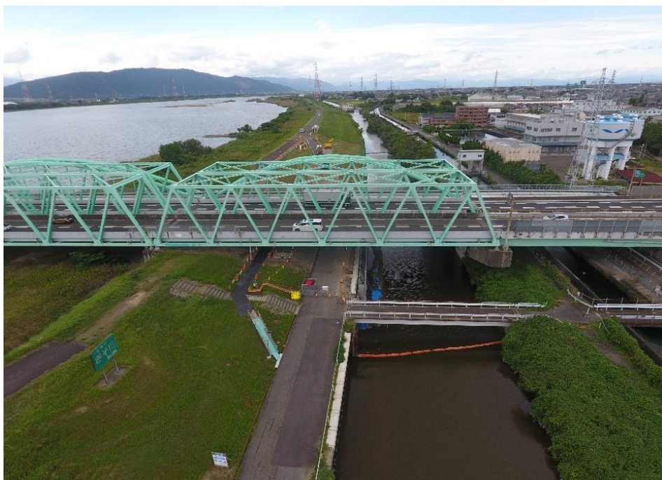
下流側より上流側を望む
