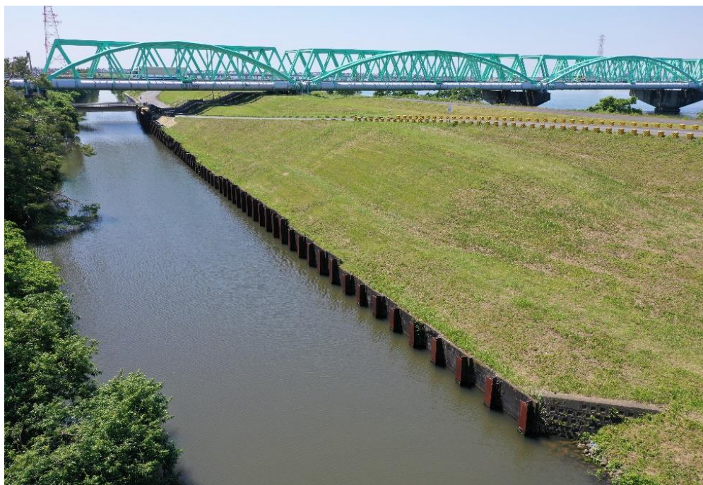
着工前（上流より）
