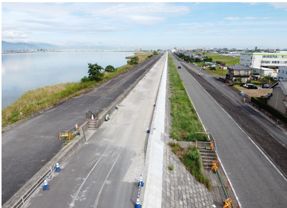
下流側より上流側を望む
