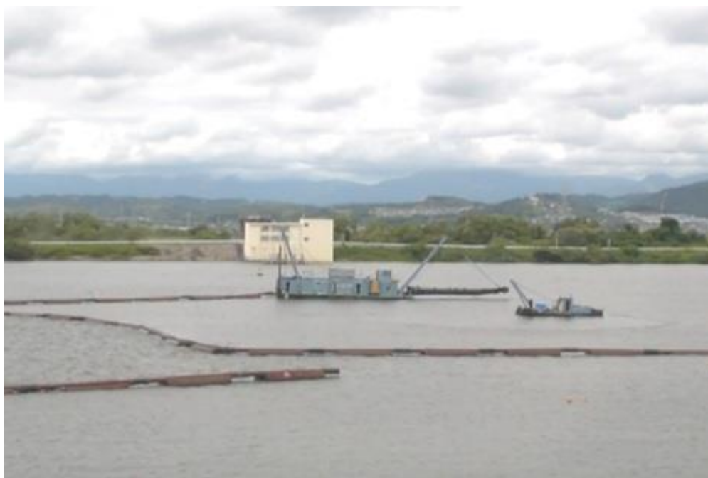
ポンプ浚渫状況
