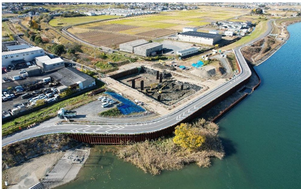
下流より上流を望む
