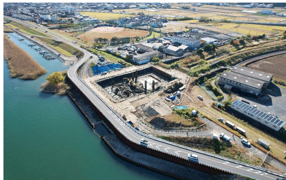
上流より下流を望む
