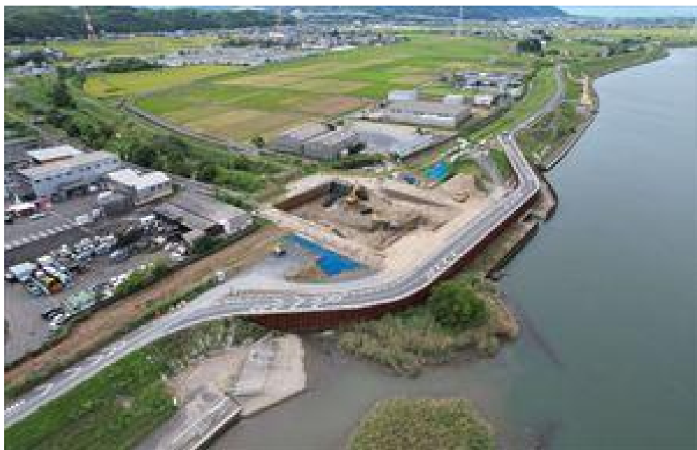
下流より上流を望む
