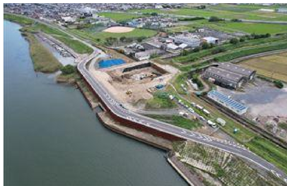
上流より下流を望む
