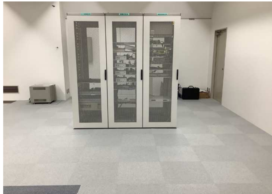
新通信機械室_完成
