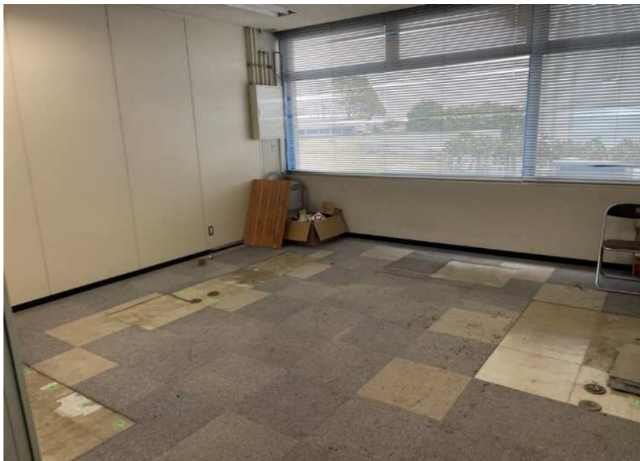
旧通信機械室撤去時
