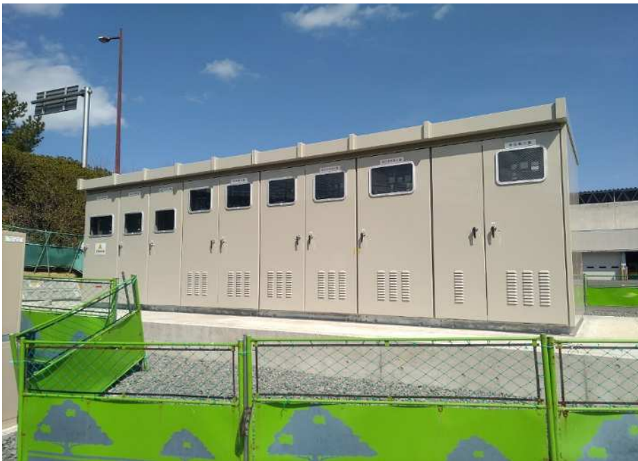
高圧受変電設備設置完了
