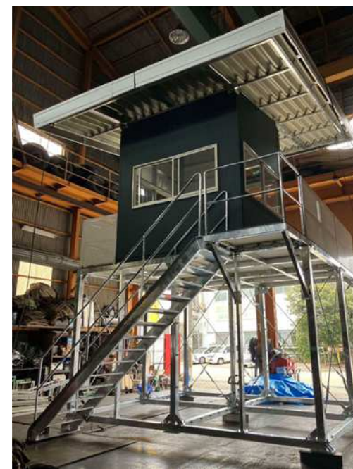
発艇塔施設工 工場組立完了時
