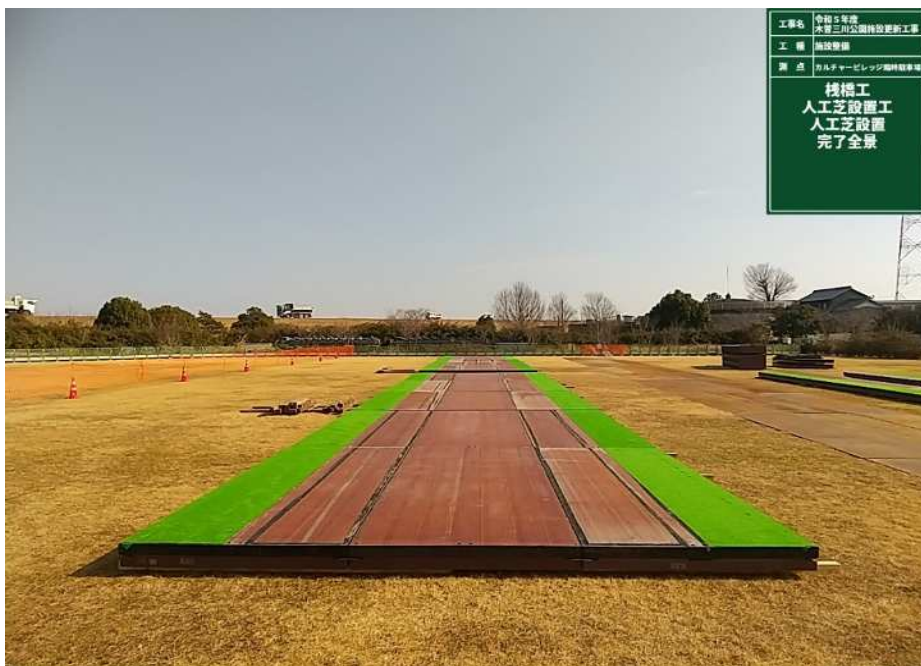
栈橋工人工芝設置工 完了全景
