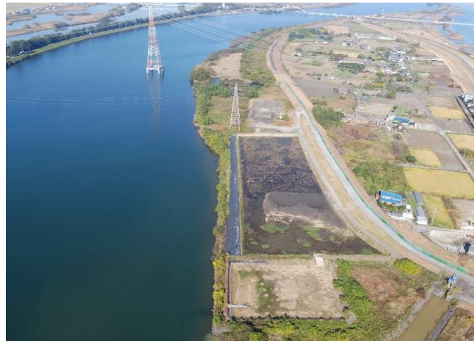
福原排砂池（下流から上流を望む）
