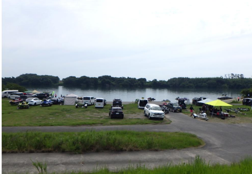
変形護岸の全景（海津市海津町外浜）
