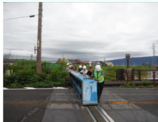
◆木曽川水系水防災協議会での取組状況 関係機関と連携した陸間操作 (R6. 8台風10号時) (大垣市塩田橋陸間)
