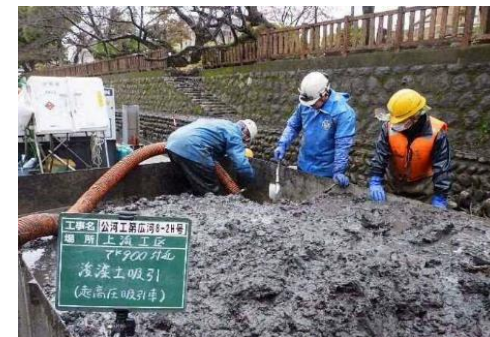
◆水門川河床掘削状況(県)
