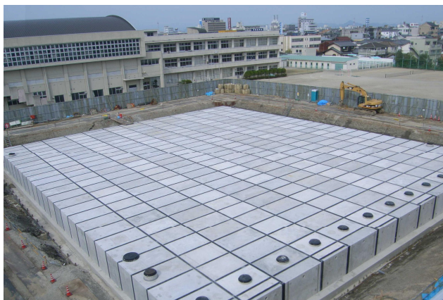
◆大垣市による雨水調整池整備 (美和雨水調整池：大垣市立南中学校グラウンド地下)
