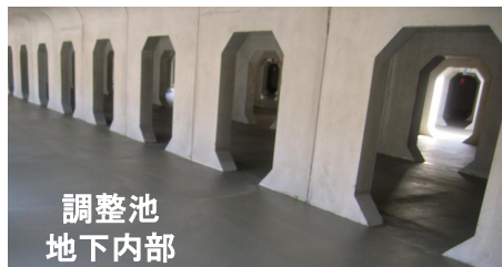
◆大垣市による雨水調整池整備 (美和雨水調整池：大垣市立南中学校グラウンド地下)
