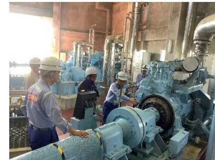
3号高弾性継手故障確認
