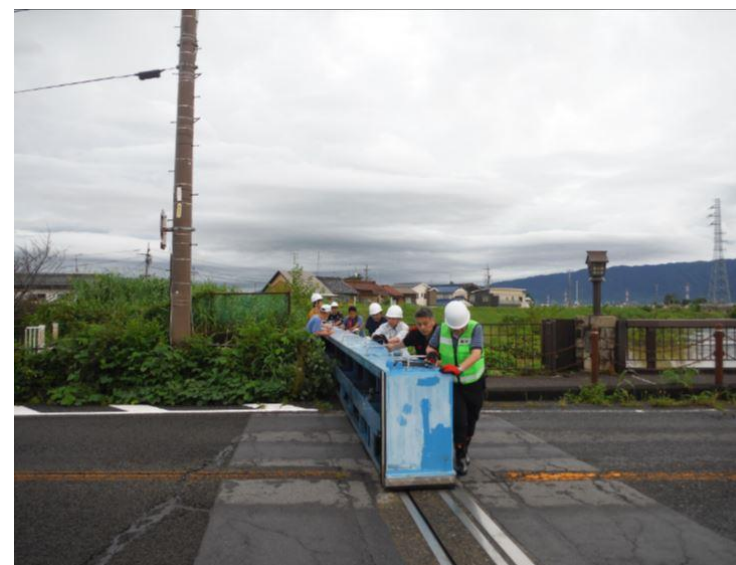
塩田橋陸閘の閉鎖状況
