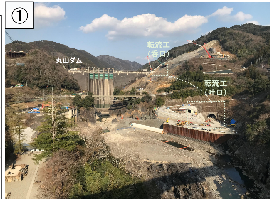
堤体（下流より上流を望む）
