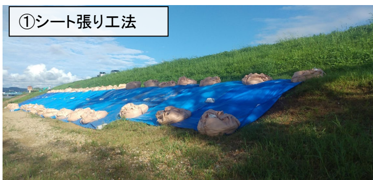
応急復旧完了 (8月18日17時頃)
