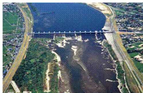
木曾川大堰付近(平成6年渇水時)
