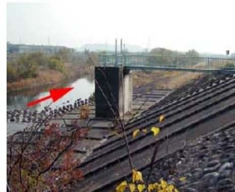
堤防の損傷なし
