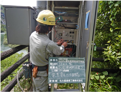
電気通信施設の点検
