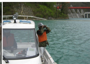
貯水池の巡視・監視
