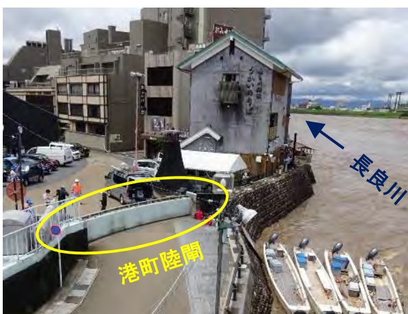
長良川の小規模陸閘閉鎖状況 52.3k付近 (7月8日10時頃)
