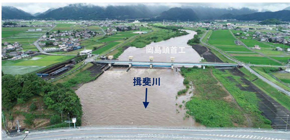
揖斐川の出水状況（7月8日10時頃）56.6k（岡島頭首工付近）
