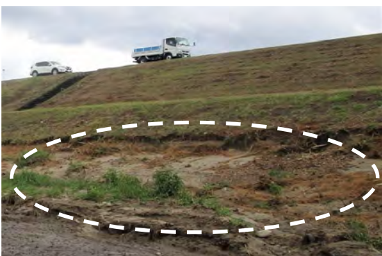
木曾川左岸67.8k 堤防川表の法崩れ状況 （可児市土田地区）
