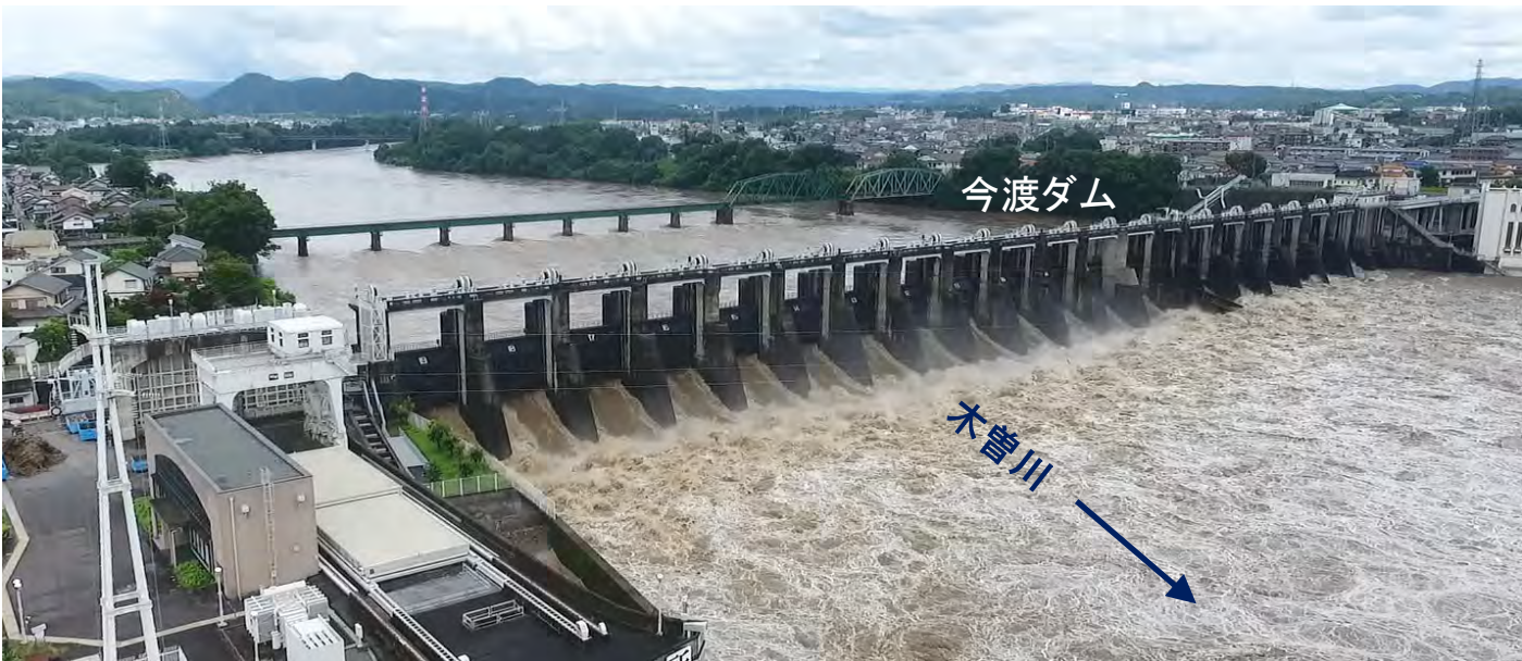
木曾川の出水状況（7月8日12時頃）70.4k付近
