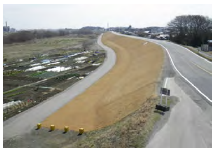
施設の修繕(護岸)
