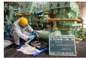
機械・電気施設の点検
