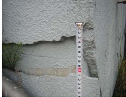
写真 上屋壁面部コンクリート剥がれ（新水門川排水機場）
