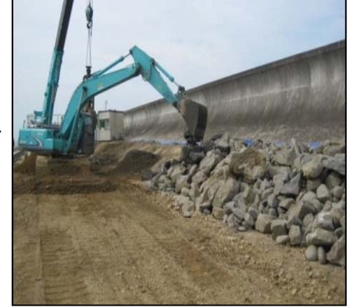
撤去された支障物(巨石)
