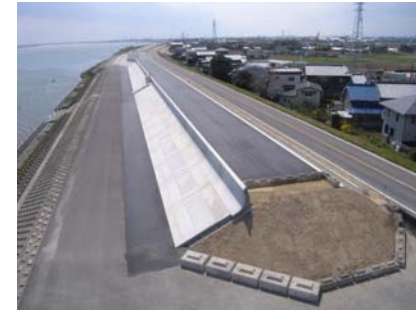
高潮堤防(施工中の状況)
