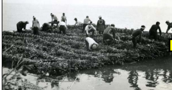
粗朶沈床を組み上げ
