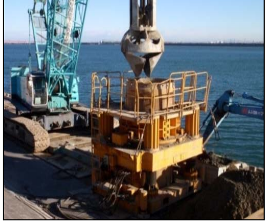
ハンマグラブによる支障物除去
