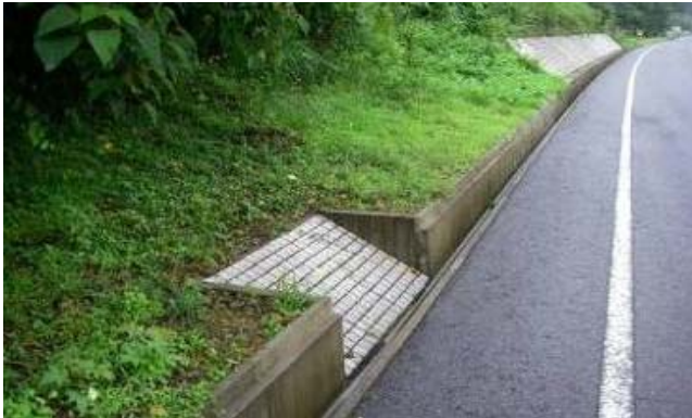
這い出し用スロープ付き側溝の設置
