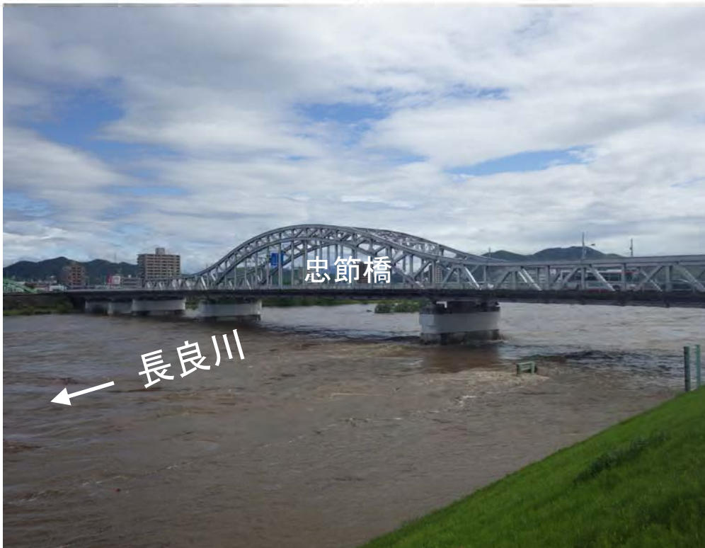
長良川の出水状況（4月25日9時頃）忠節橋付近
