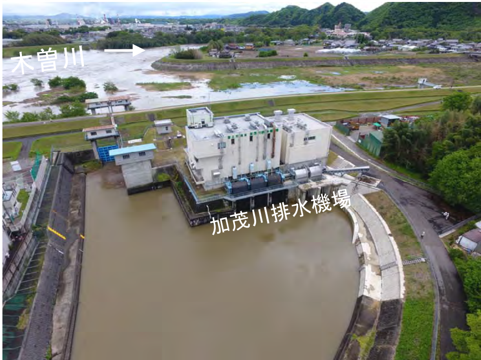
かもがわ 加茂川排水機場の稼働状況（4月25日11時頃）木曽川右岸66.6k付近
