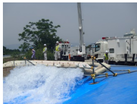
TEC-FORCEによる 緊急排水活動訓練
