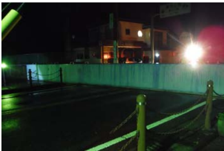
塩田橋右岸陸閘 (10/23 2:15閉鎖)
