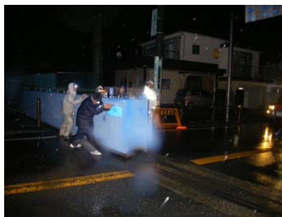
塩田橋右岸陸閘閉鎖作業中
