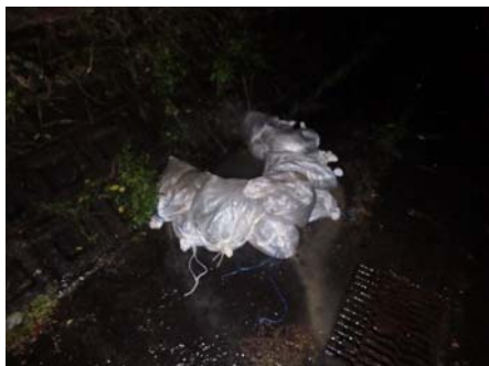
牧田川10.4k付近 月輪工法
