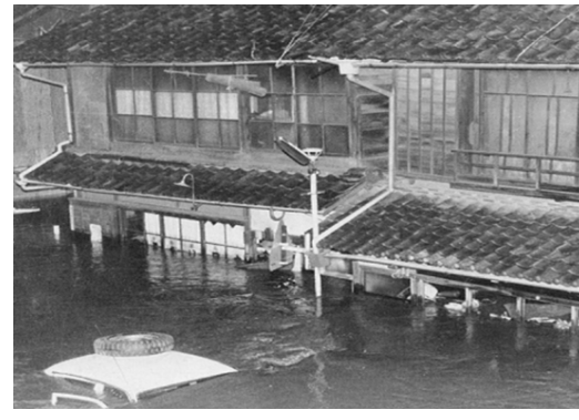
美濃加茂市内 被災状況
