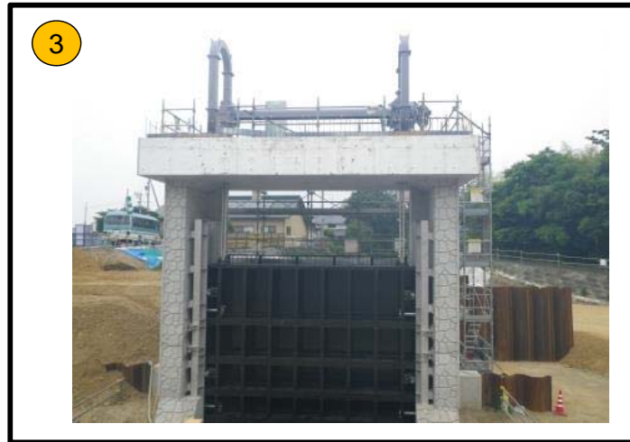
平成27年度 犀川遊水地新堀川樋管改築工事 【H29.10完成】
