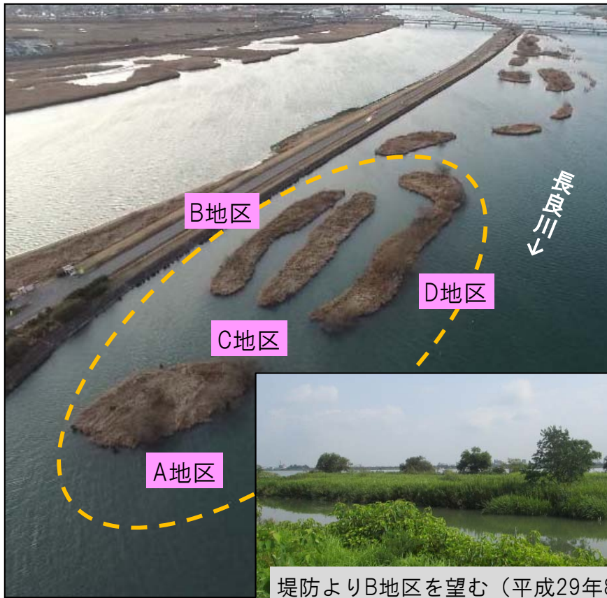
再生したヨシ原の状況（長良川右岸6.0k付近）
