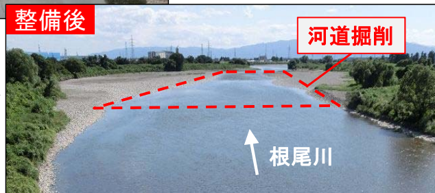
維持管理掘削の実施状況(根尾川6k付近)
