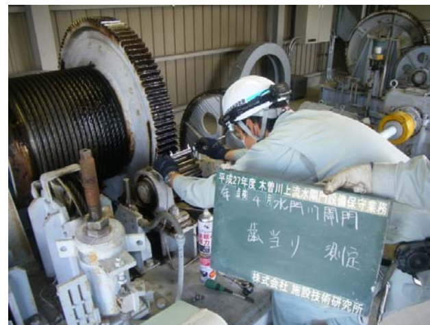
水門川閘門の点検状況
