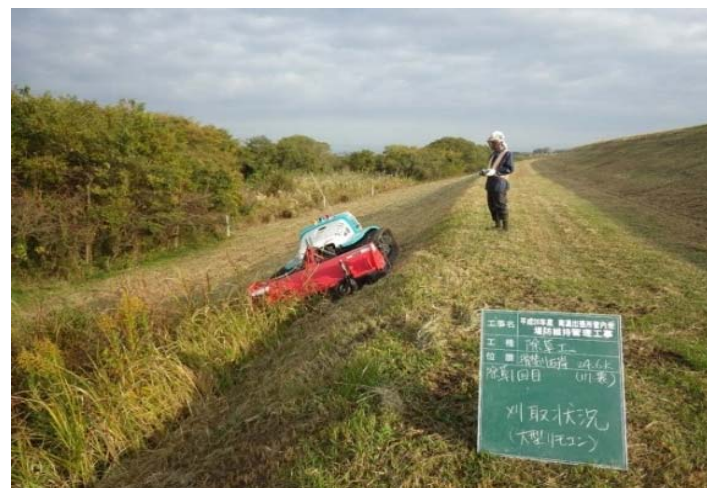
大型機械の遠隔操作による除草状況
