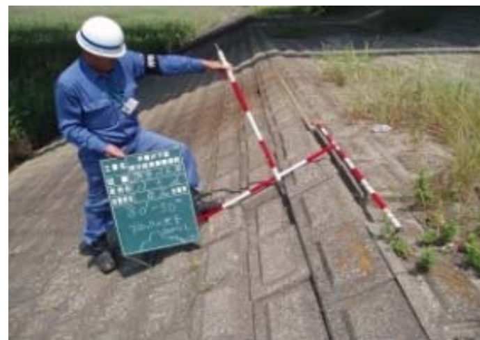
護岸施設損傷点検状況
