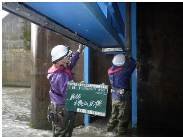
加茂川水門の点検状況
