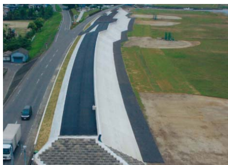
ヤトミシマエガス 弥富市前ヶ須地区(木曽川左岸8.0k付近)
