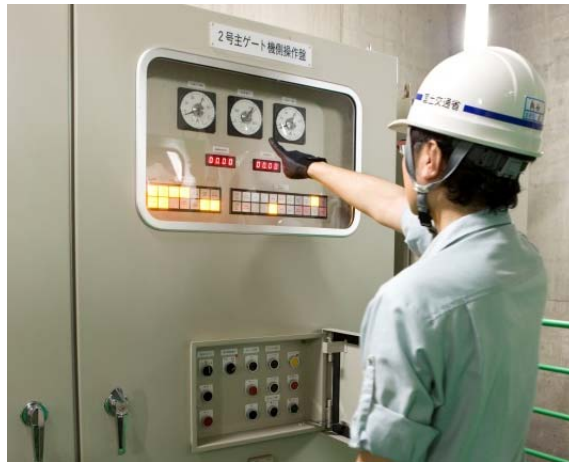
放流前ゲート点検状況
