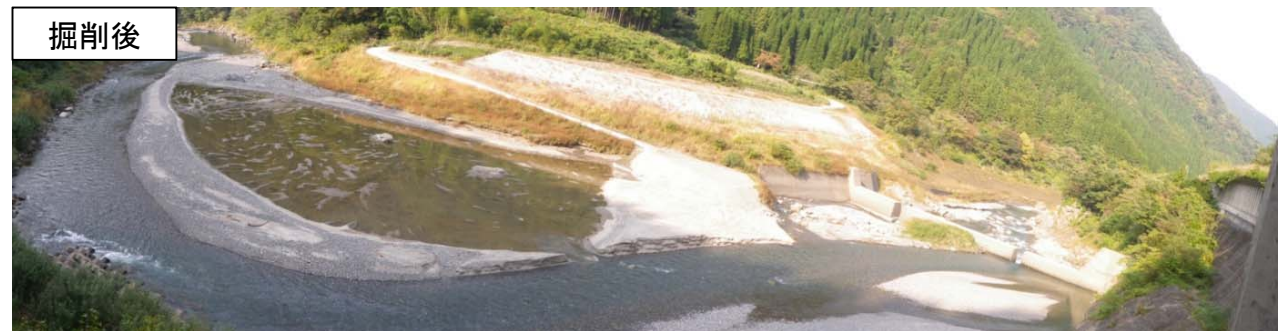
堆積土砂掘削工事の実施状況
