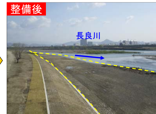
河道掘削の整備前後の状況(長良川41~42k付近)
