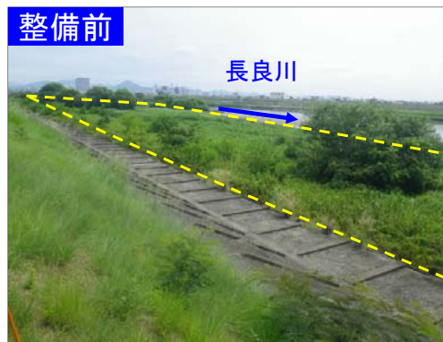
河道掘削の整備前後の状況(長良川41~42k付近)
