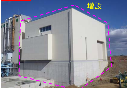
加茂川排水機場
