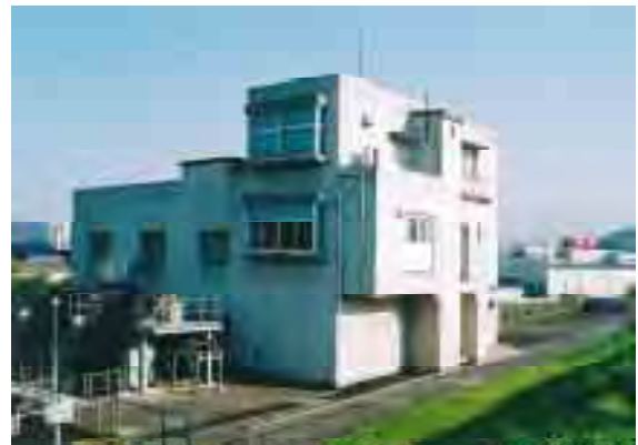
写真4.3.2 函南観音川排水機場
