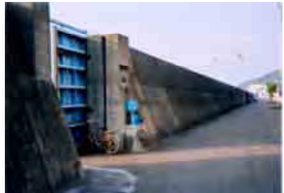
写真2.1.1 左岸の高潮堤及び陸閘
