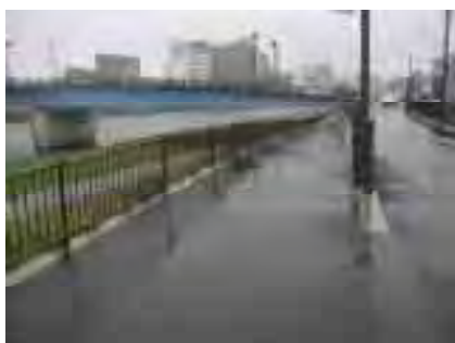
写真4.3.29 アンダーパス(永代橋)
