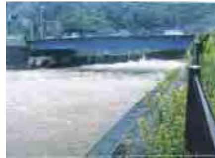
写真4.3.27 洪水時の狩野川放水路
