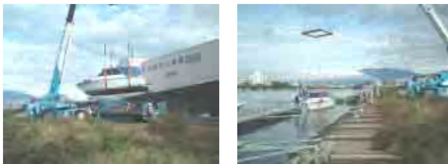
写真4.3.20 簡易代執行による不法係留船の撤去
