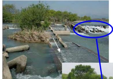
濁筋の変化や河床の低下により流量が減少したときに魚道の機能が発揮できない
