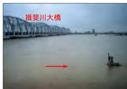
桁下高不足の橋梁の洪水時の状況
