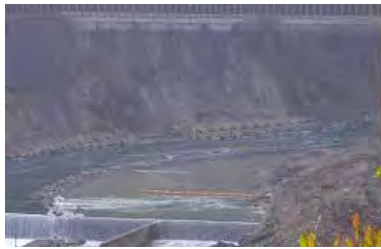
貯砂ダム上流の掘削状況（横山ダム）
