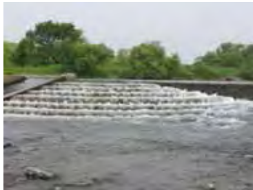
揖斐川第7床固魚道（神戸町・揖斐川）
