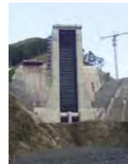
徳山ダム選択取水設備
