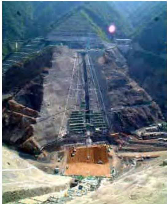
コアフィルターの盛立(河床部)、 基礎処理(右岸着岸部)の施工状況 平成15年6月撮影 (左岸側より河床部及び右岸を望む)
