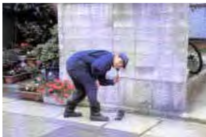
聴音棒による漏水調査
