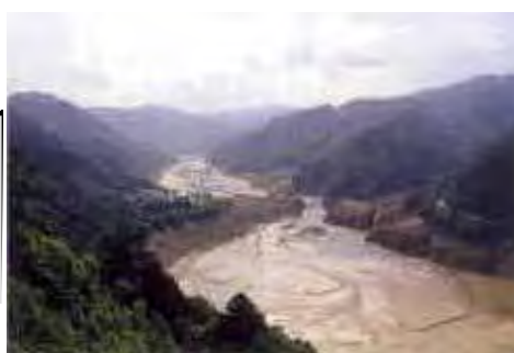
牧尾ダムの堆砂状況(H6.7)
