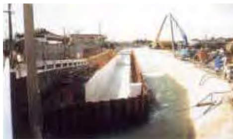
幹線水路等施設改築の施工状況
