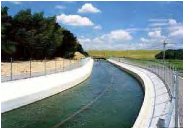
愛知用水二期完成水路 (諸輪開水路) 平成12年11月撮影
