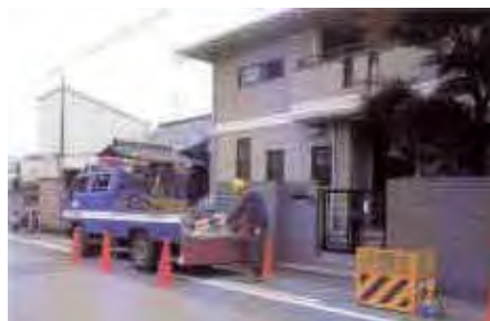
漏水探知装置による漏水調査
