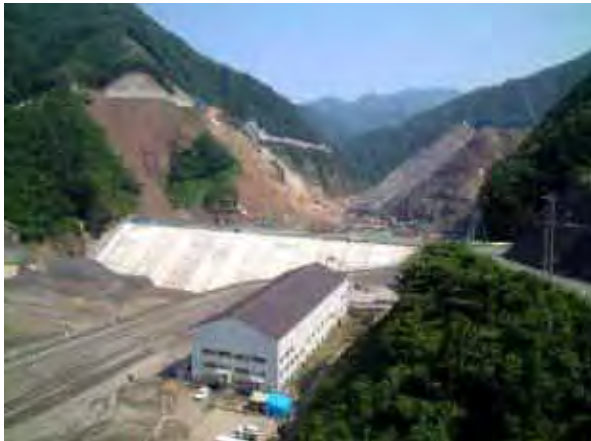
本体盛立施工状況(手前は上流二次締め切り) 平成15年6月撮影 (右岸上流よりダムサイトを望む) ※上流二次締め切りは、H14.7完成
