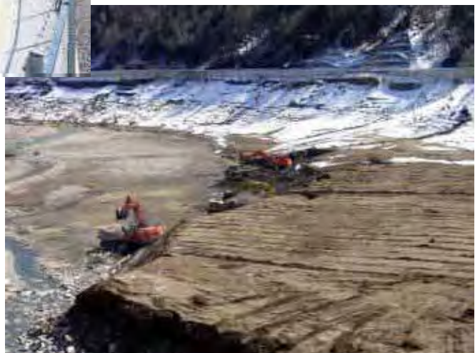
牧尾ダム湖内堆砂除去工事状況 (大岩橋下流部) 平成15年3月撮影
