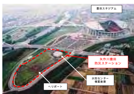
矢作川豊田防災拠点
