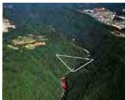
設楽ダム建設予定地
