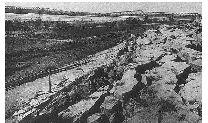
明治24年濃尾地震による長良川鉄橋（東海道本線）と堤防の被害状況 出典：「1891年の日本の大地震」（岐阜県歴史資料館蔵）
