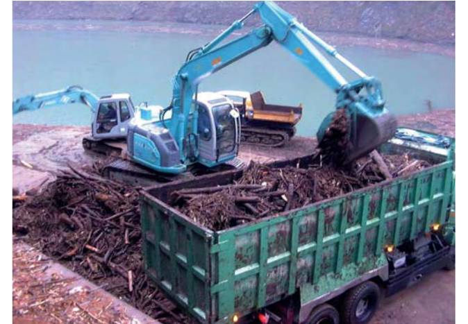
流木の積込(横山ダム)
