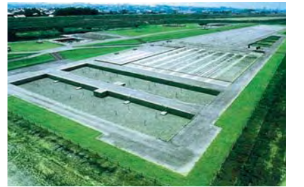
支川浄化施設(境川)
