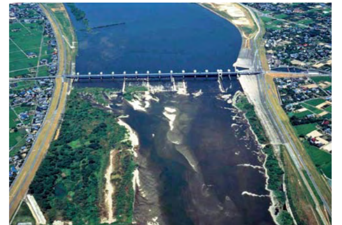
平成6年渇水時には、木曽川大堰からの放流量がほぼ0m³/sまで減少し、河川環境に影響を与えました
