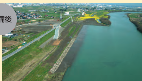
河道掘削・樹木伐開
