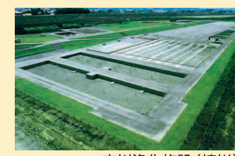
支川浄化施設(境川)
