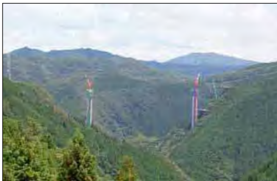
新旅足橋下部工完成 (H19. 2)
