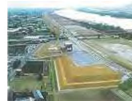
河川防災ステーション (木曽川高畑地区)
