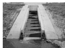
樋管の魚道改造事例
