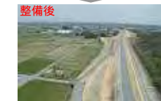
築堤（杭瀬川 5.6k付近）
