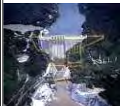
新丸山ダム（建設中） 《木曾川》
