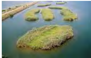
浚渫土を用いたヨシ原の造成 (長良川6km付近)
