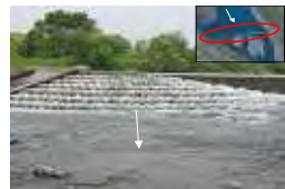
魚道の改善事例（階段式パノラマ魚道）
