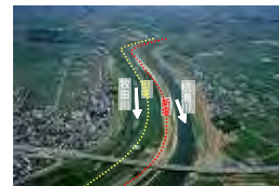
引堤（牧田川・杭瀬川背割堤）
