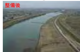
河道掘削（揖斐川 37.0k付近）
