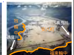
S51.9洪水の状況 輪中堤の機能
