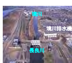
境川排水機場
