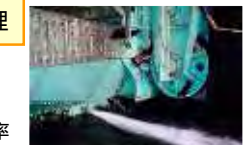
常用洪水吐ゲートの漏水の状況(丸山ダム)
