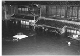
S58.9 木曽川における被災状況
