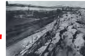
濃尾地震による長良川鉄橋（東海道本線）と堤防の被害状況 出典：「1891年の日本の大地震」（岐阜県歴史資料館蔵）
