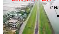
揖斐川右岸14.2k付近
