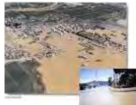
H14.7 揖斐川支川の被災状況
