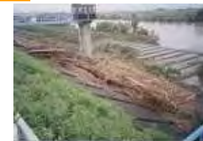
揖斐川流木の状況(34.6km左岸付近)
