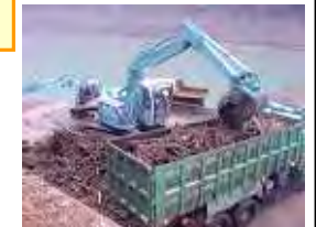
流木・ゴミの積込(横山ダム)
