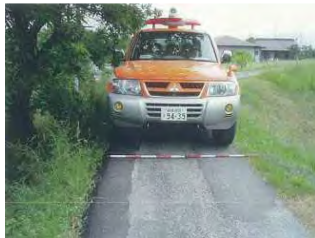
杭瀬川左岸7.8k付近
