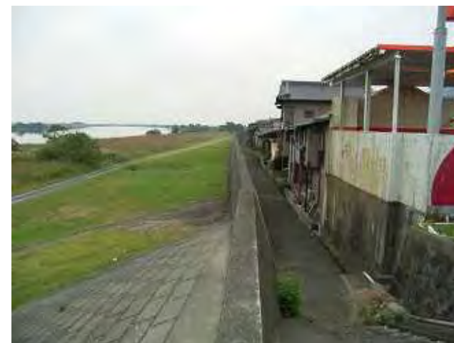
揖斐川右岸19.4k付近
