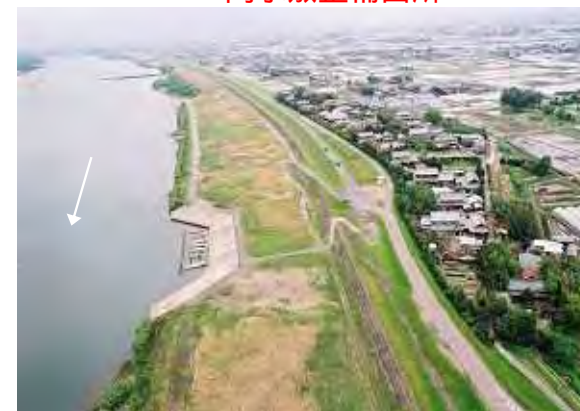
木曽川左岸19.6k付近
