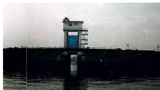
改築前の伊曾島水門 （揖斐川左岸2.0k - 6.0m）
