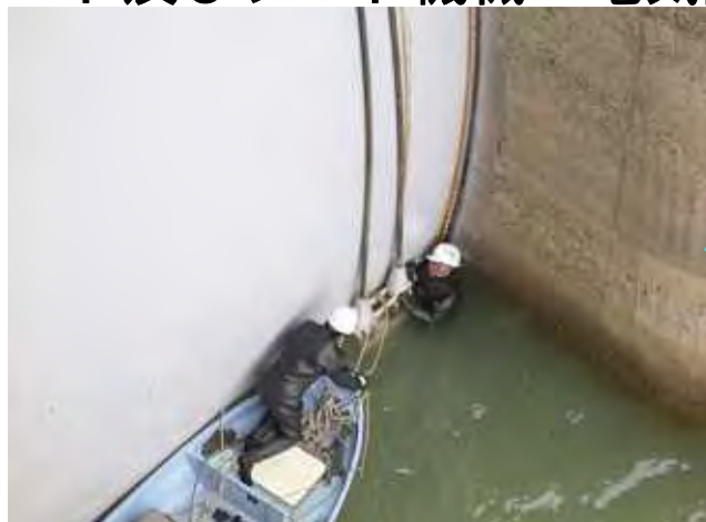
非常用洪水吐ゲート巻上ワイヤーの取替状況（横山ダム）
