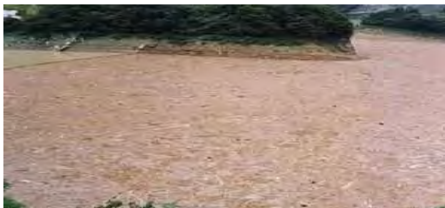
流木・ゴミの漂着状況（横山ダム）
