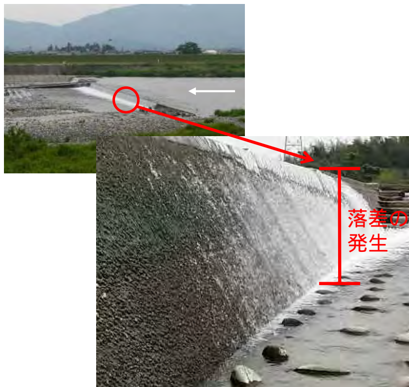
根尾川第7床固（7.8k付近） 落差は1.3mあり、魚類等の遡上は困難
