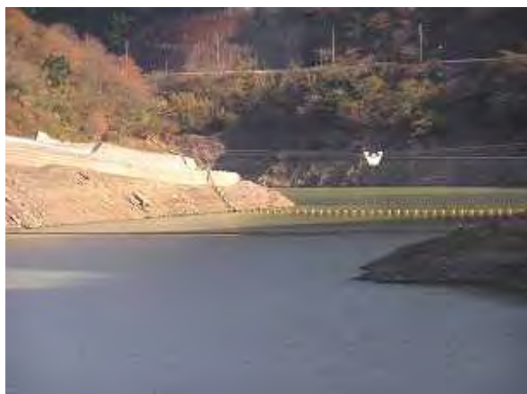
横山ダム汚濁防止フェンスの状況
