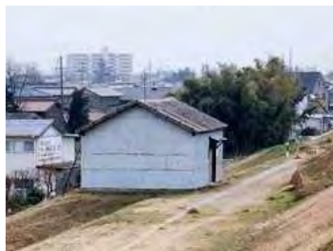
玉ノ井水防倉庫 (一宮市)
