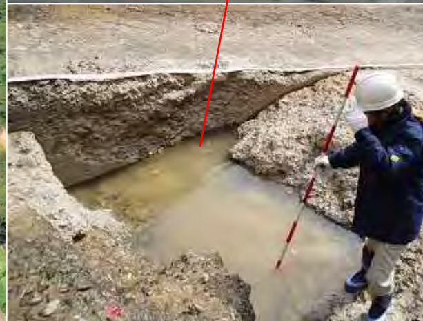
減勢工の損傷状況（横山ダム）
