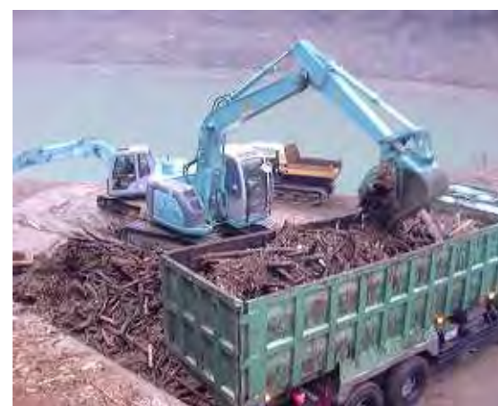
流木・ゴミの積込（横山ダム）
