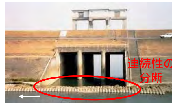
犀川溢流樋門（長良川39.6k付近右岸）
