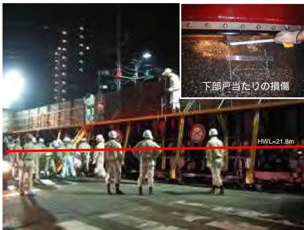
長良陸閘（長良川右岸52.8k） （昭和37年完成）
