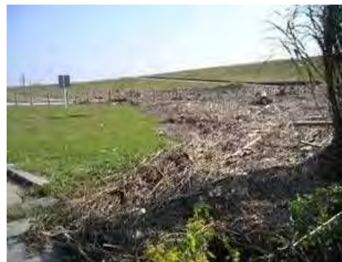
木曾川流木の状況(26.4k左岸付近)
