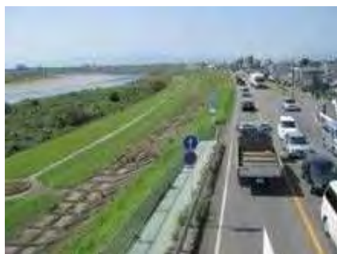
兼用道路の状況 (長良川右岸50k付近 忠節橋より下流)
