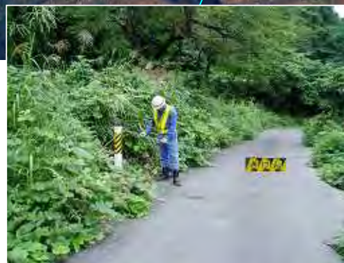
安全施設の点検
