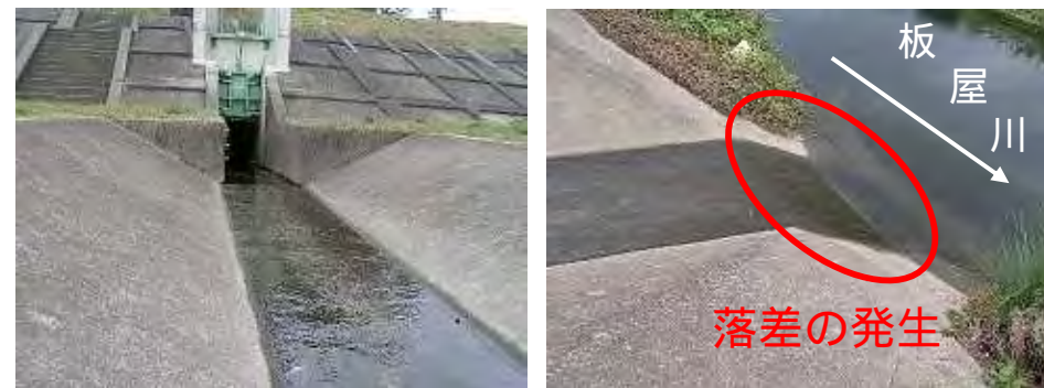
福満排水樋管（伊自良川3.6k付近右岸）
