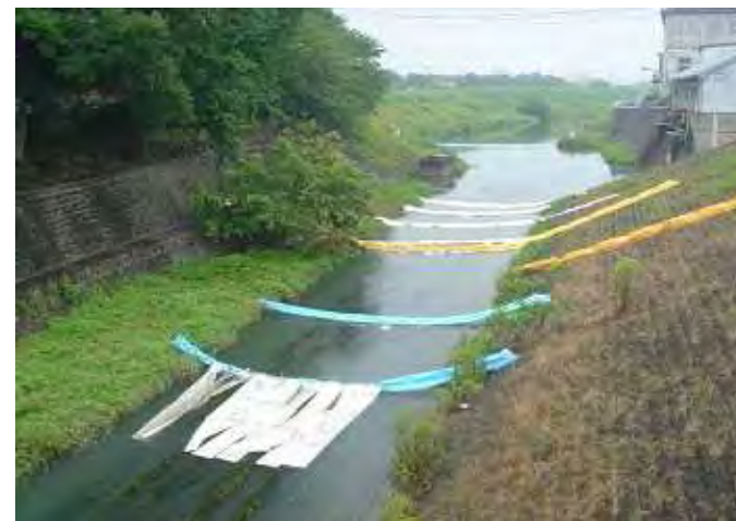
オイルフェンスによる対策状況 (長良川距離標の39.6k付近)
