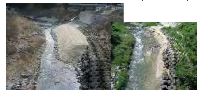
ダム下流に土砂供給（阿木川ダム）
