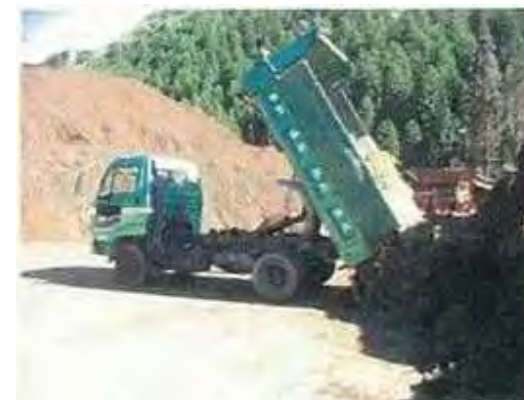
持出処理 (リサイクル施設)
