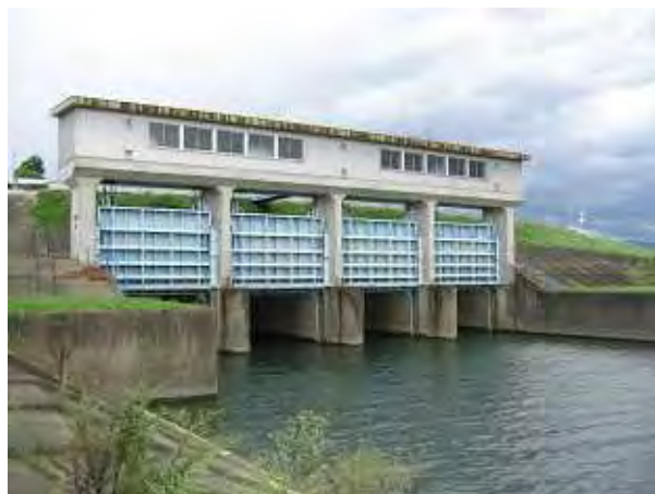
平野井川樋門 (揖斐川)
