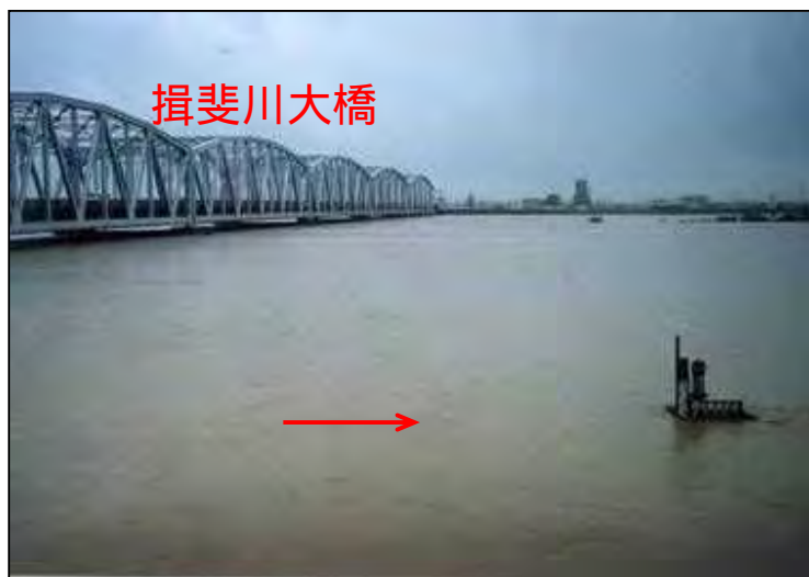
洪水時の橋梁の状況(H14.7.10) (計画高水位を上回った万石地点)
