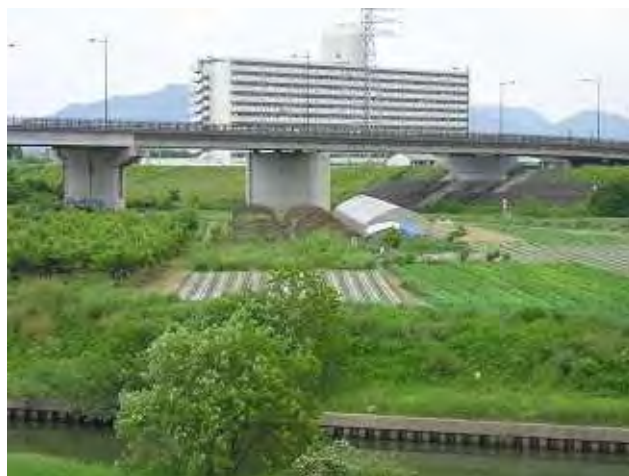
ビニールハウス 設置状況 (伊自良川右岸 1.4k)
