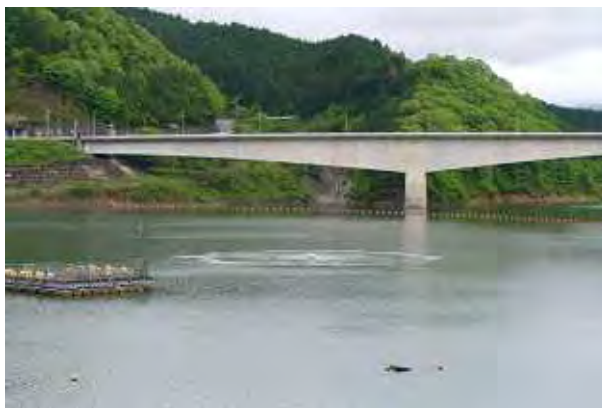
阿木川ダムの曝気循環の状況
