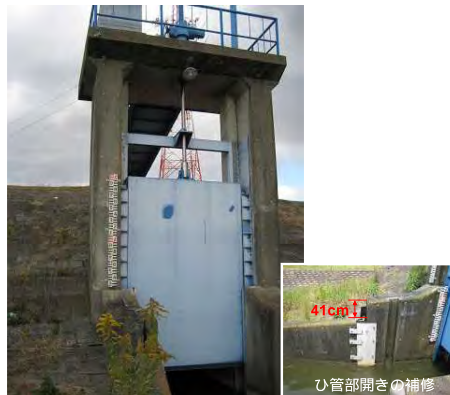
千倉排水機樋管（長良川左岸7.4k） （昭和50年完成）
