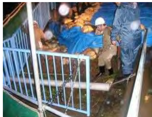
H16.10.20 長良川（岐阜市高川原） 日置江水防団100名による水防活動（月の輪工）
