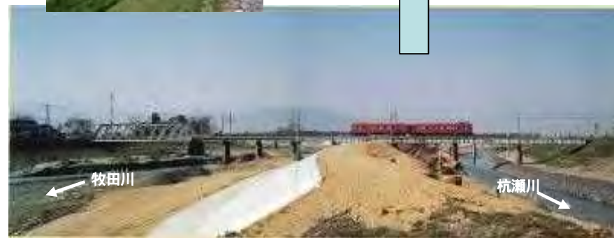
改修前の近鉄牧田川橋
