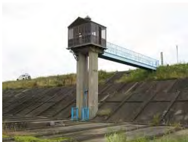
東島樋管 (長良川)
