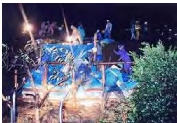
H16.10.21 牧田川（養老町祖父江） 養老町水防団25名による水防活動（くい打ち土嚢工）
