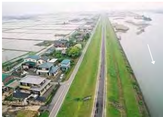
揖斐川右岸14.2k付近
