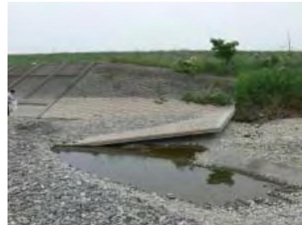
低水護岸損傷 (揖斐川左岸46.8k+70)
