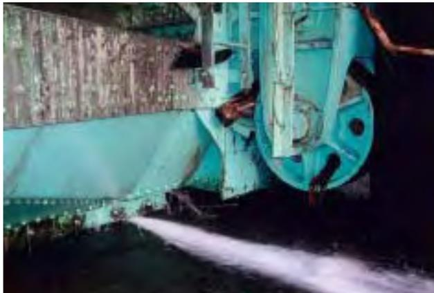
常用洪水吐ゲートの水密ゴムの劣化による漏水の状況（丸山ダム）
