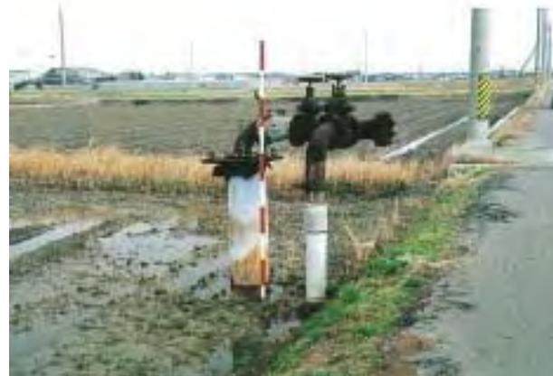
地盤沈下による井戸の抜け上り状況（木曾岬町）
