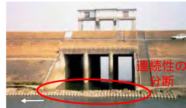
犀川溢流樋門（長良川39.6k付近右岸）
