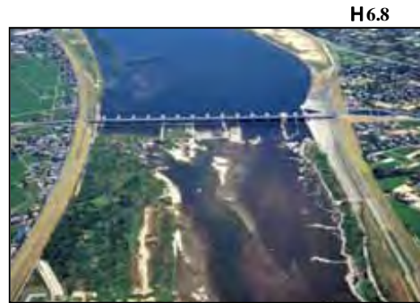
木曾川大堰下流では川底が見える状況となった
